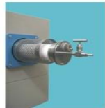
7. 分多次轮流拧紧三颗螺栓确保法兰不偏斜
