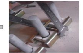
(4) 卸下固定瓷夹螺丝
